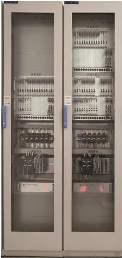
左图为计轴机柜，内含计轴主机，安装在设备室内，由计轴板和诊断板组成。计轴板完成轨道区段的“占用/空闲”检测功能，实现与微机联锁的接口。诊断板完成计轴系统的诊断功能，实现与微机监测的接口。
